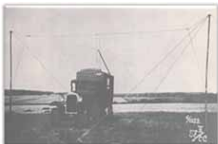
Рисунок 6 – а) Передатчик и б) приемник РУС-1 «Ревень» – первый советский серийный радиолокатор. Принят на вооружение в 1939 году, использовался войсками ВНОС РККА. Произведено 45 комплектов.
